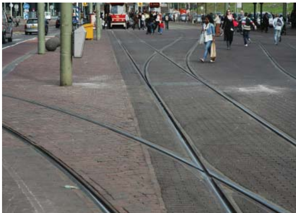
Baksteenklinkers zijn moeilijk toepasbaar bij tramrails.
