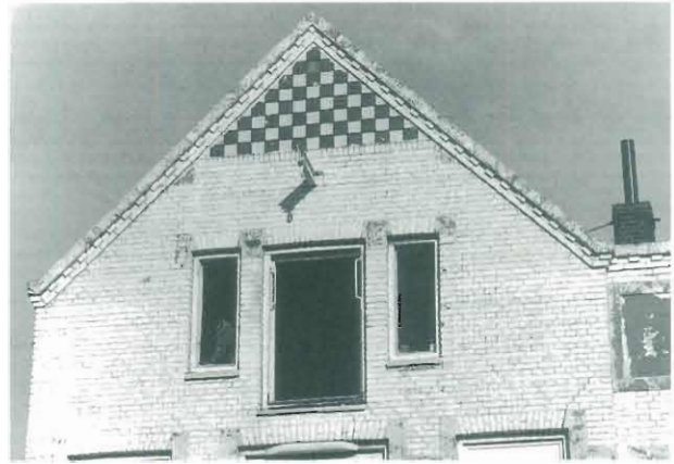
Fijnjekade 17-21, detail, 1990 (foto dienst REO).
