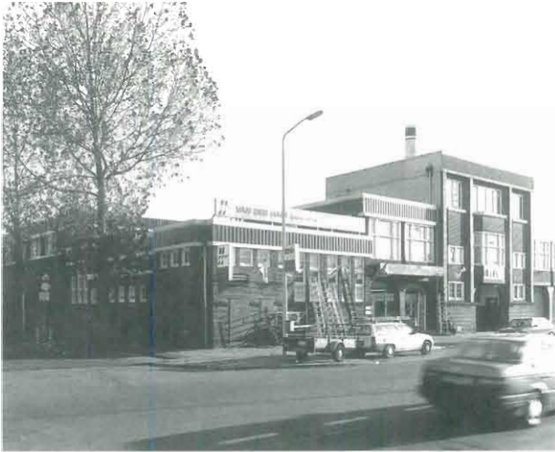
Waldorpstraat 276, gebouw van de vroegere Coöperatieve Wasscherij, 1991 (foto dienst REO).
