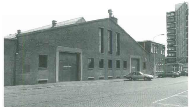
1e van der Kunstraat 282, bedrijfshal van de RAC met driehoekige gevel, 1991 (foto dienst REO).
