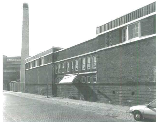
Leeghwatersstraat, achterkant van de Coöperatieve Wassche- rij, 1991 (foto dienst REO).
