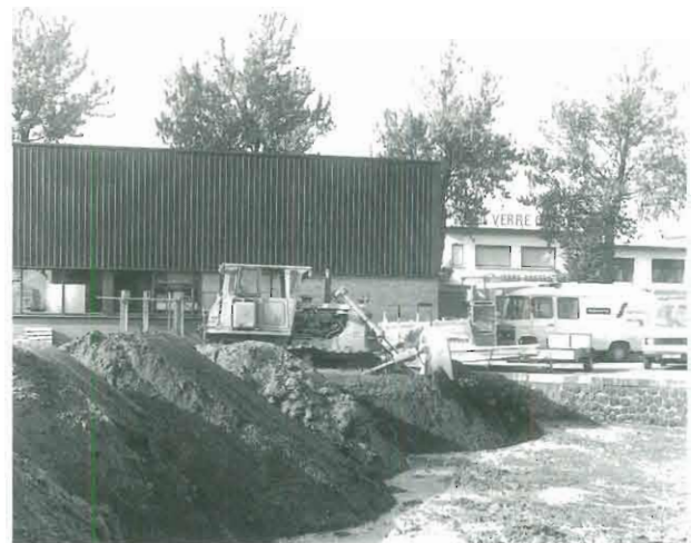
Het dempen van een havenarm, 1990 (foto dienst REO).
