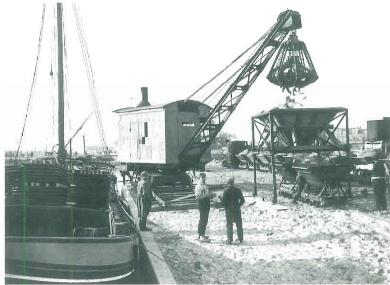
Werkzaamheden aan de kaaimuren van het Laakkanaal, jaren twintig (Haags Gemeentearchief).
