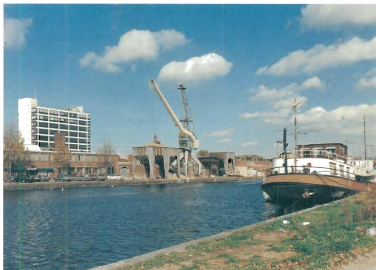
De Calandkade, met kraan en vultrechter, gezien vanaf de Neherkade, 1991 (foto dienst REO).
