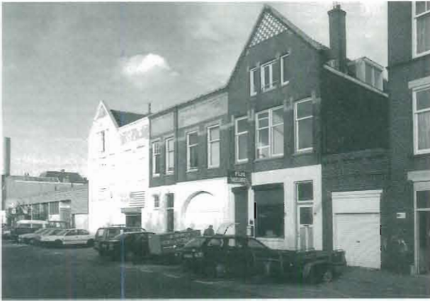
Fijnjekade 17-21, voormalig bedrijfspand van rederij Van der Schuyt, 1990 (foto dienst REO).
